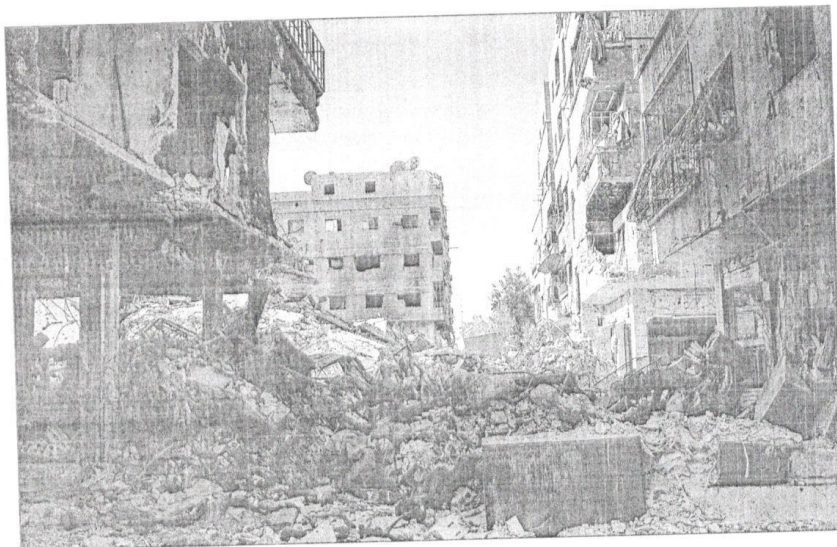
Разрушенный боевиками ИГИЛ Дамаск.
